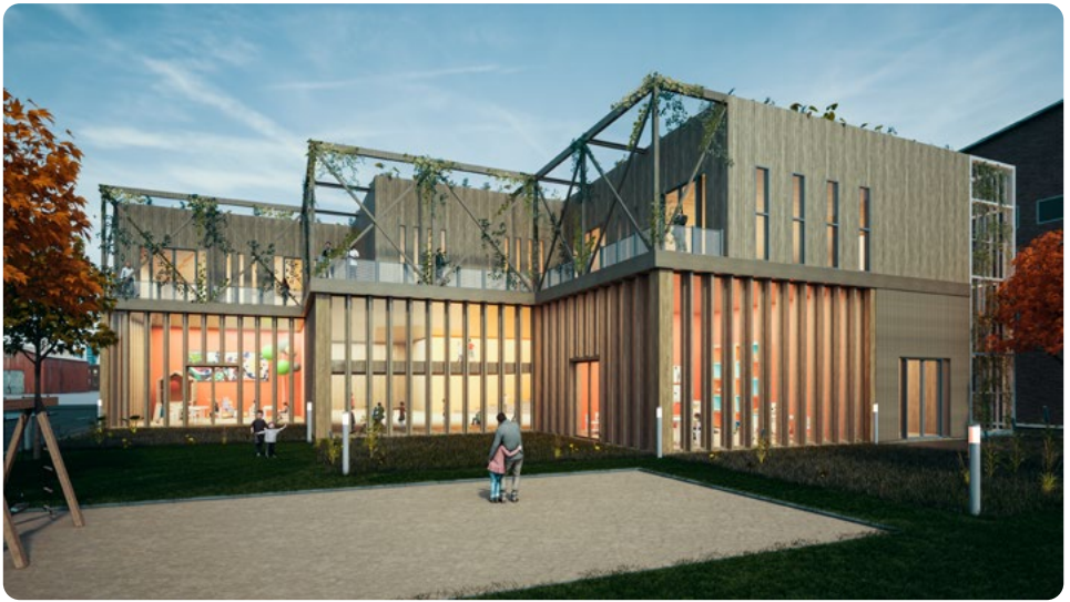
Circular House, Baustart: Ende 2024
